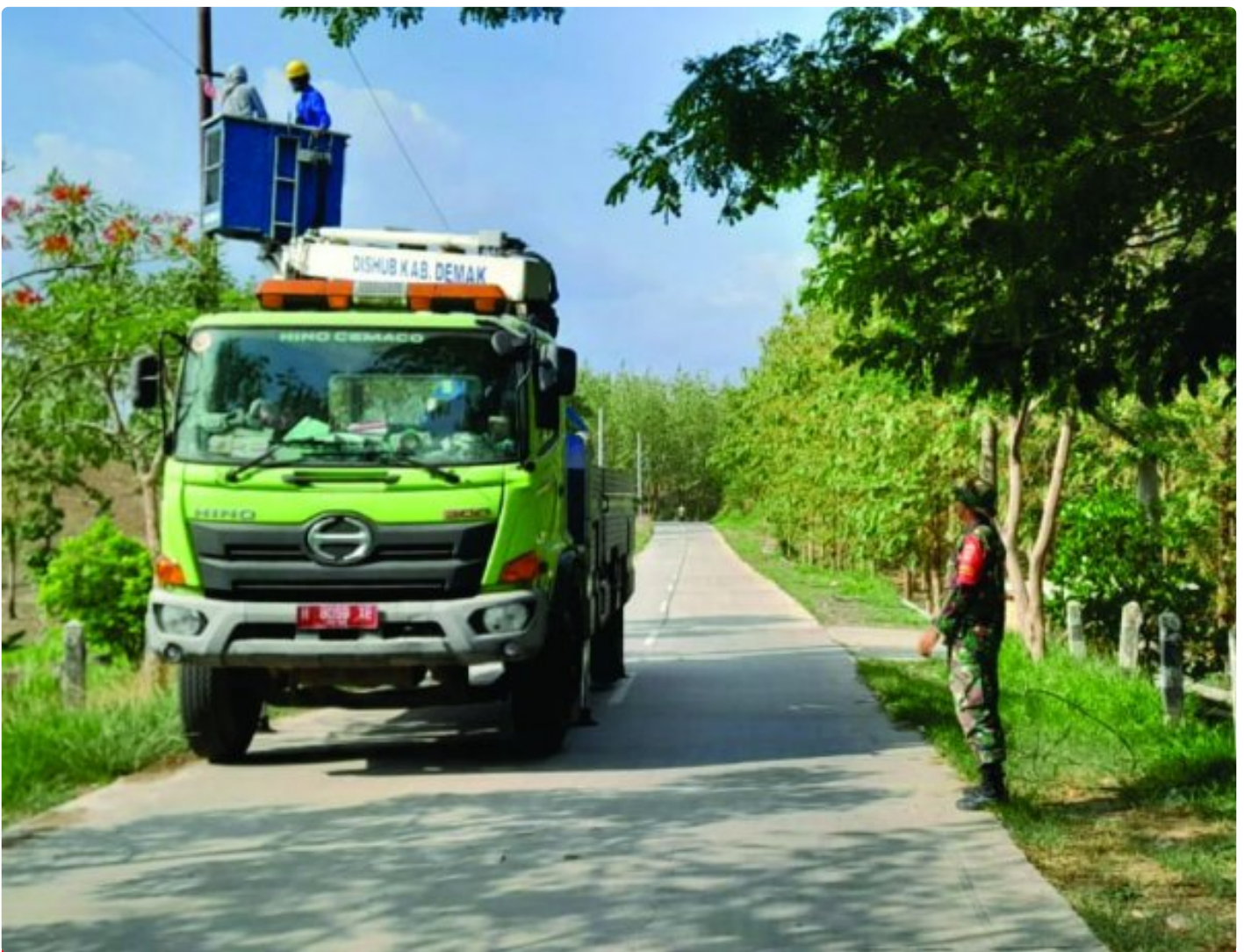
Ciptakan Rasa Aman, Babinsa Bersama PLN dan Warga Perbaiki Lampu Jalan
